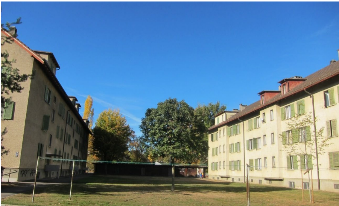
Hoffassaden mit Aussenraum und Nebengebäude (von Zelgstrasse)
